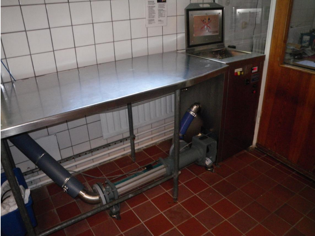
Figur 2. GTS-processorns pump och rörsystem. Foto: Ulf Nordberg
